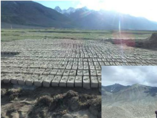
Fabrication de 1000 briques en ciment sur le site.
