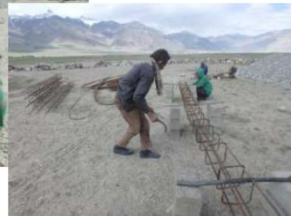
Préparation du ferrailage pour armer les piliers.
